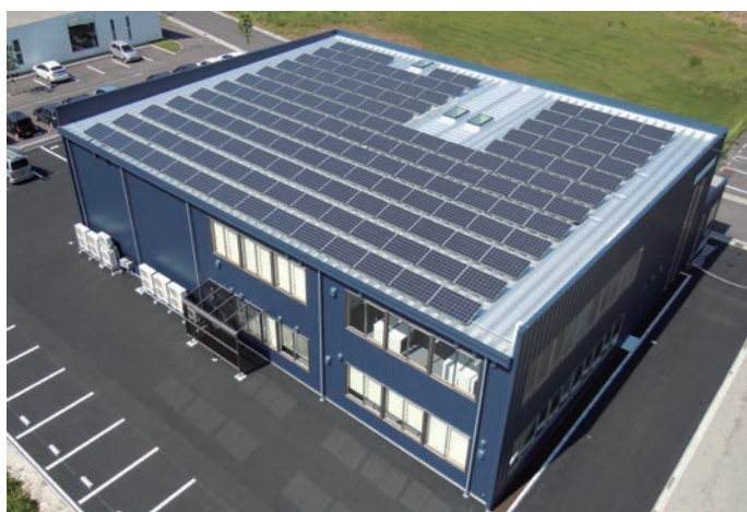
現社屋の屋上には一面に太陽光パネルを設置
